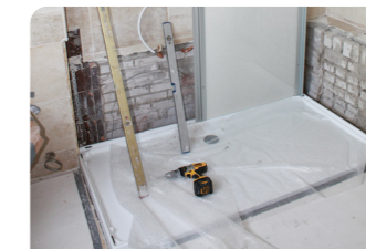
Anschlussarbeiten für Armatur, Wasser und Ablauf durchführen
