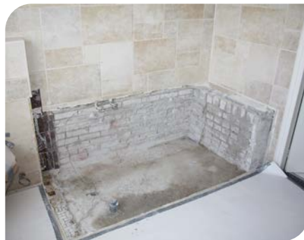
Duschwanne setzen und ausrichten
