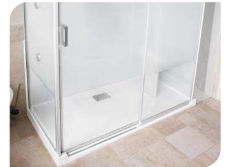
Rückwand- und Seitenwände sowie Glasfront und Türen einsetzen
